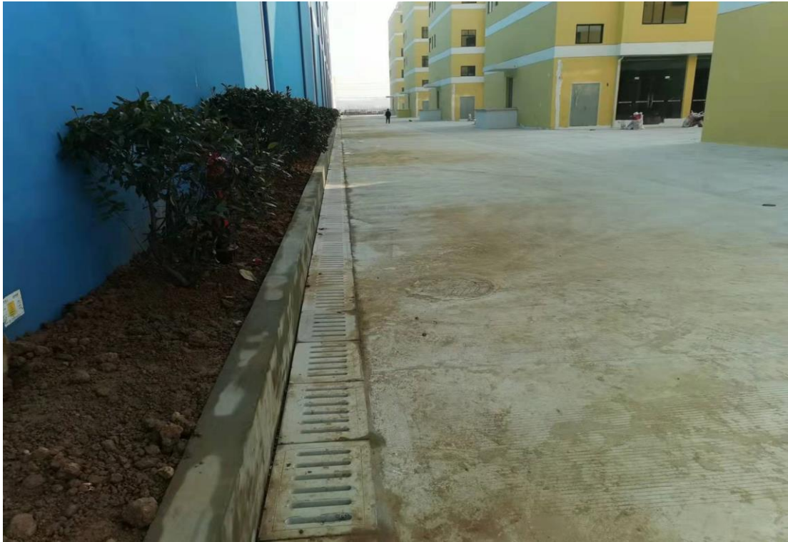
现场影像（室外绿化、盖板沟及雨水管网）
