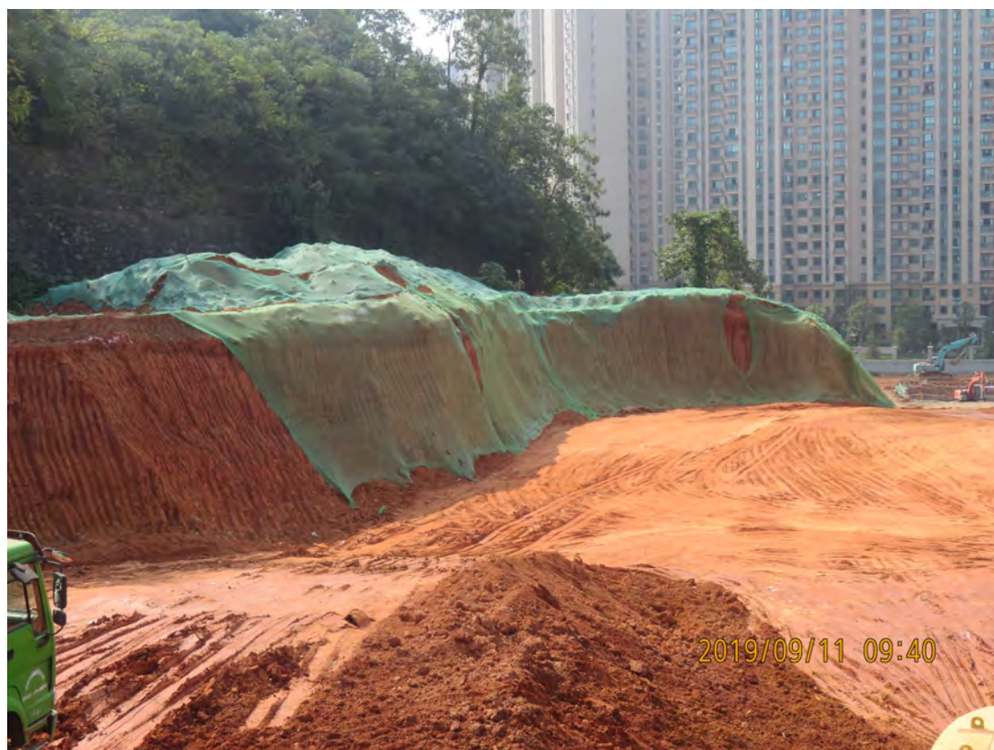
(施工过程中开挖及临时堆土重点监测部位)
