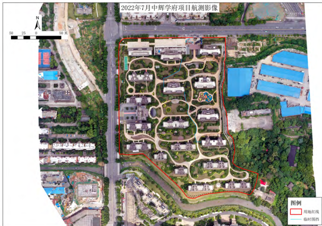
(2022年7月项目水土保持设施完成情况)
