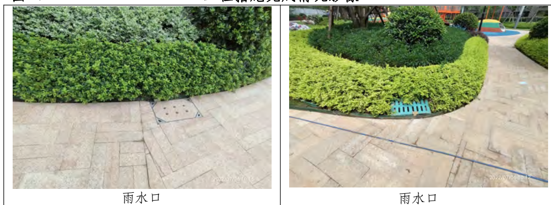
图 4.1-1 工程措施完成情况影像
