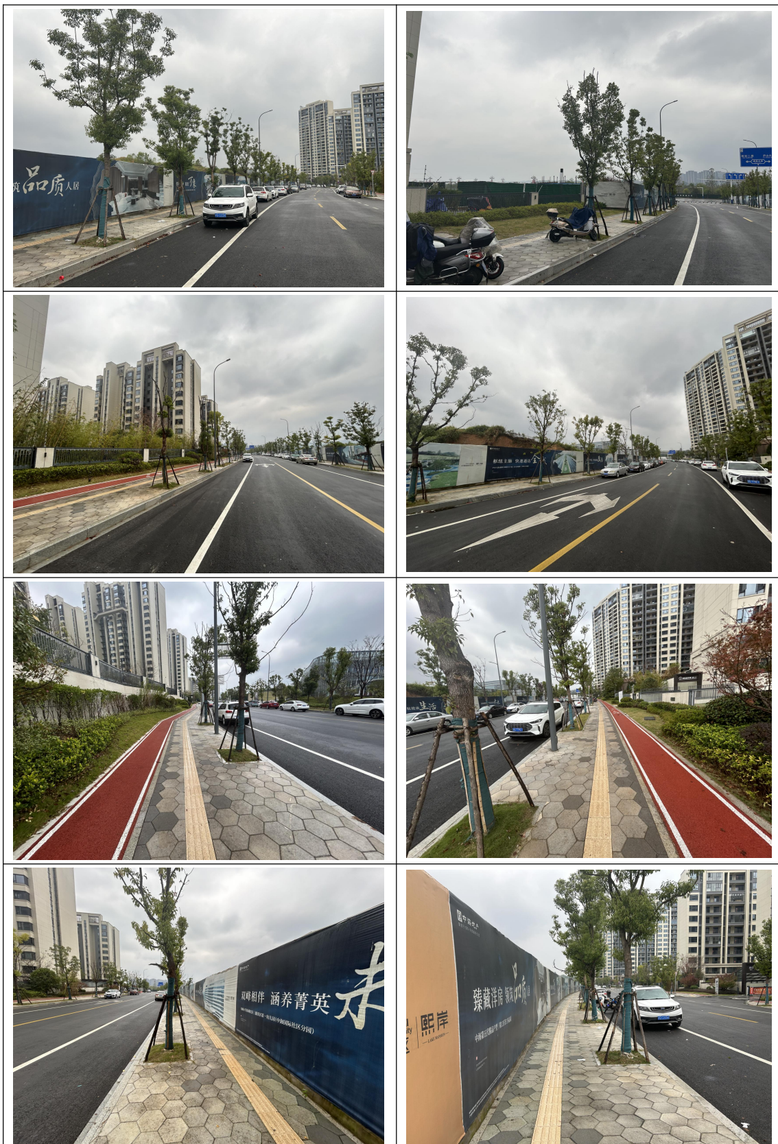
已完成水土保持设施情况
