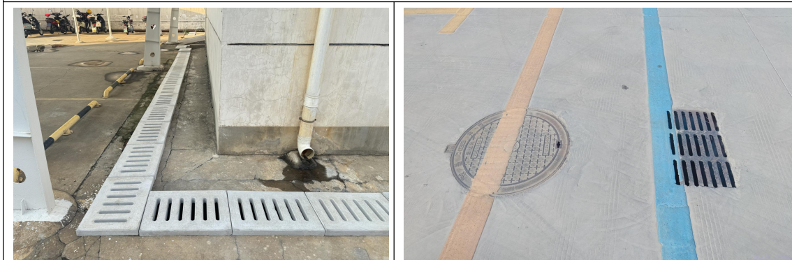
盖板排水沟现状
